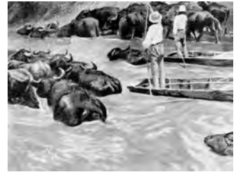
2 - Lo spurgo dei canali a Terracina
